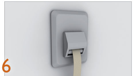
6 Abschließend Abdeckrahmen aufstecken.
