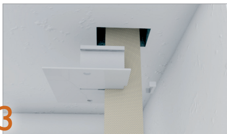
3 Gurtband einziehen. Montage auch ohne Demontage des Gurtes durch 2-teiliges System möglich.
