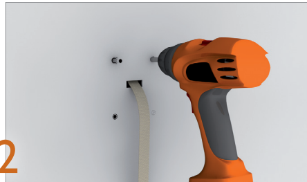
2 Vorbohren und Dübel setzen.
